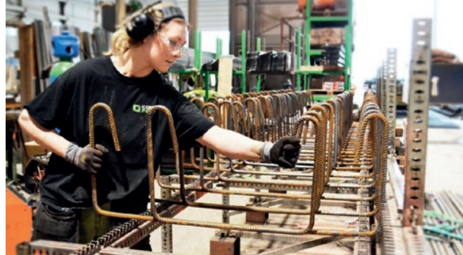
Strzemiona dla belek są umieszczane na siatce konstrukcyjnej systemu SKEW JIG.
