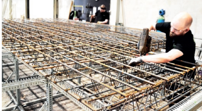
Montaż zbrojenia dla ściany zespolonej z wykorzystaniem systemu SKEW JIG.
