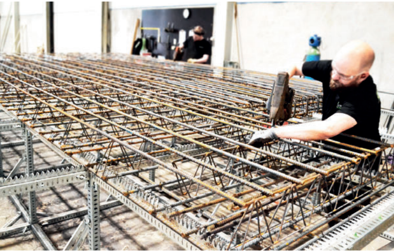
Assemblage d'un prémur sur le système SKEW JIG
