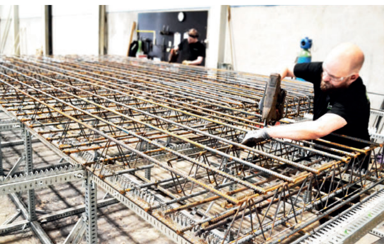
Doppelwandmontage auf dem Skew-Jig-System
